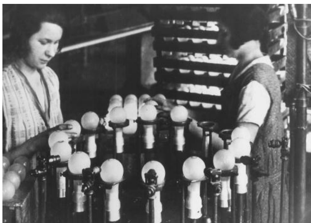
23. Lámpabélyegző automata a Tungstram gyárban. 1930-as évek
